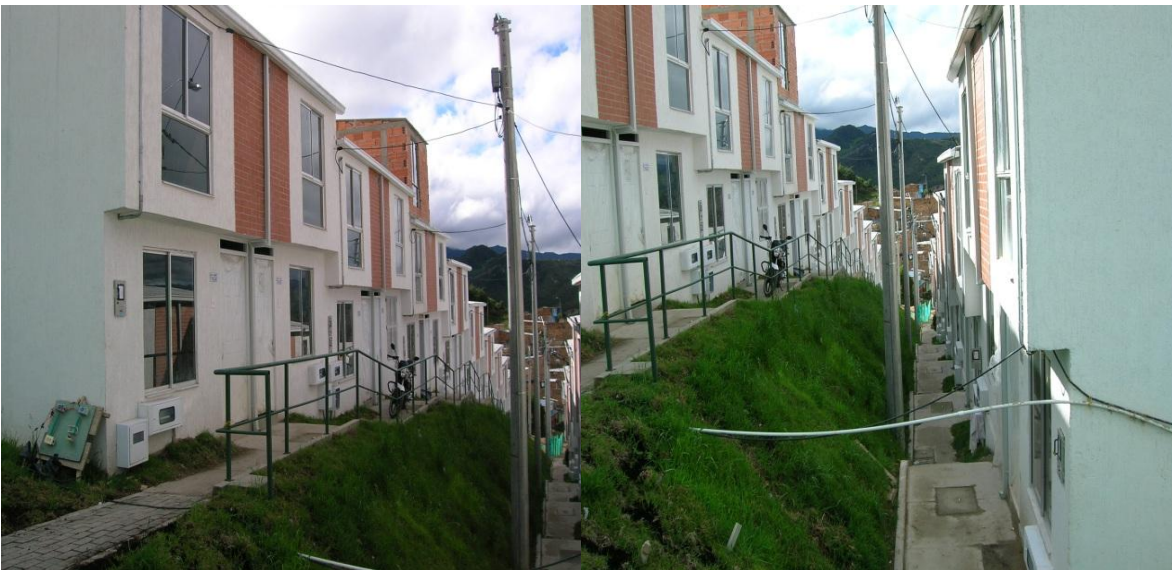
Conjunto residencial Rincón de Bolonia – CI 79 sur No 7A-08 Este. Fuente: Elaboración propia – fotografías tomadas en diciembre de 2013.
