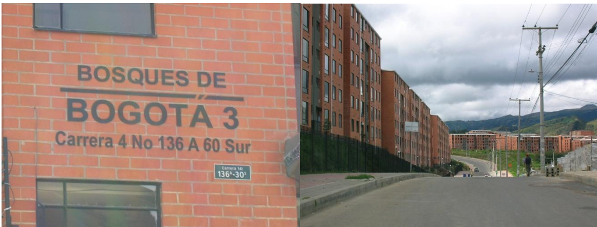
Conjunto residencial Bosques de Bogotá III-Carrera 4 No 136A 60 sur.
