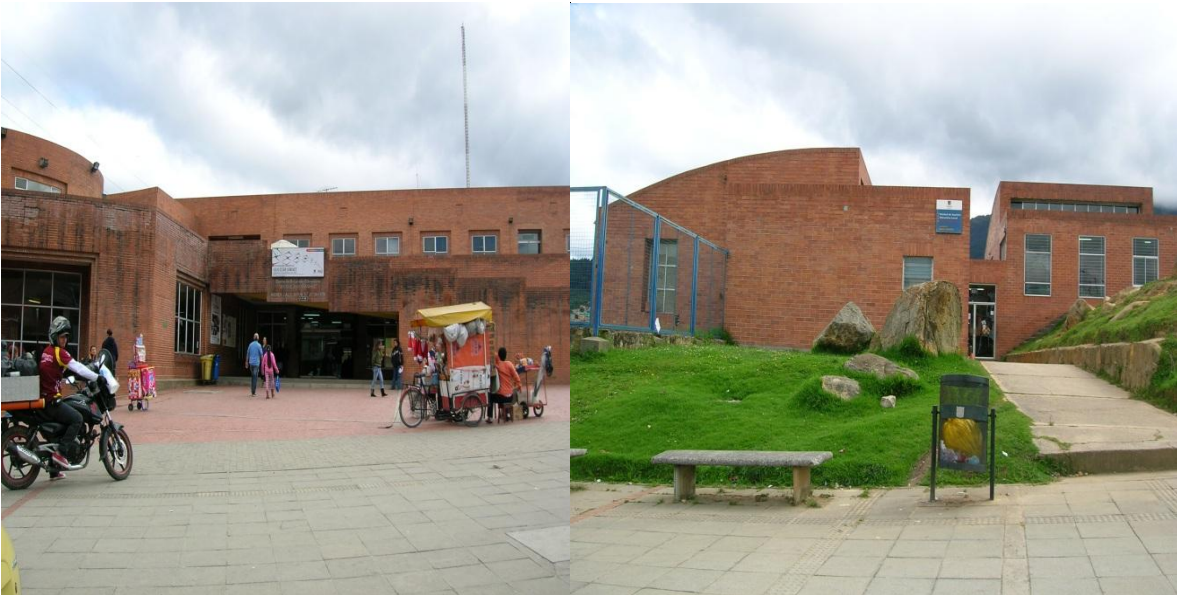
Centro de gestión educativa. Calle 91 sur No 3c-34 sur. Fuente: Elaboración propia – fotografías tomadas en octubre de 2012
