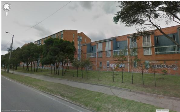
Vivienda en PH. Portal de Santafé IV. Avenida Boyaca con TV 44
