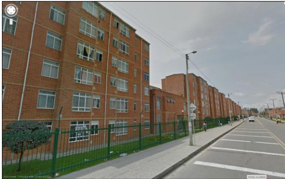
Vivienda en PH. Conjunto Residencial Torres de Tintalá II. CL 6 A con KR 90 C
