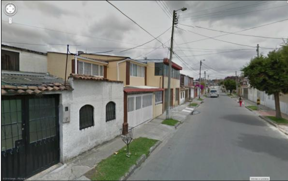
Vivienda en NPH. Barrio Castilla. KR 77 con CL 9
