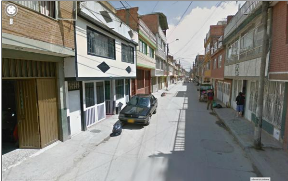
Vivienda en NPH. Barrio Patio Bonito. KR 87 C con CL 35 Sur
