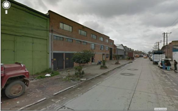
Zona de industrias y bodegas. Alquería la Fragua. KR 68 A con CL 39 Sur
