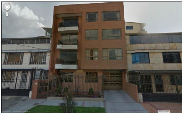
Vivienda en PH. Edificio Berna II. CL 10 Sur con KR 10 A
