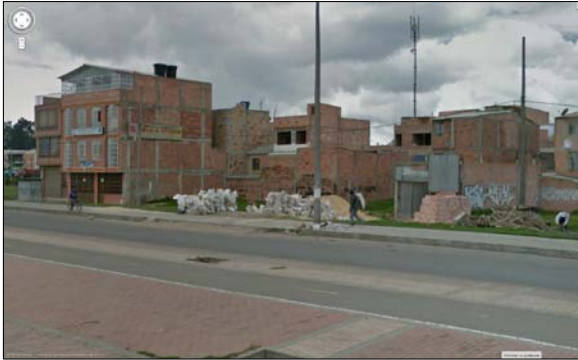
Vivienda en NPH. Barrio El Portal del Sol. KR 95 A con CL 74 A Sur
