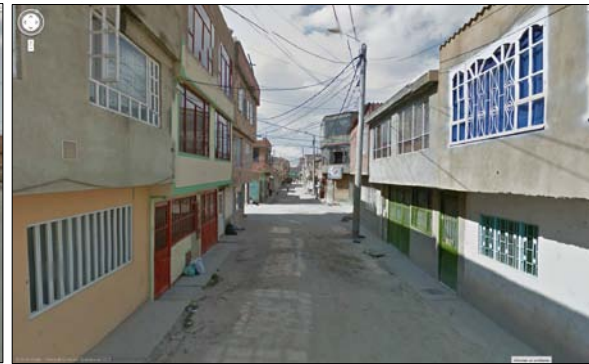
Vivienda en NPH tipo autoconstrucción. Santafé de Bosa. CL 58 Sur con KR 95 A
