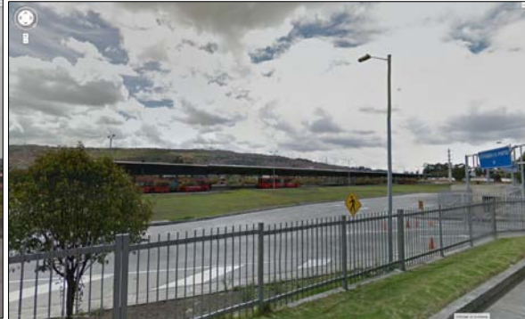
Portal de Transmilenio del Sur. CL 57 K Sur con KR 72 D
