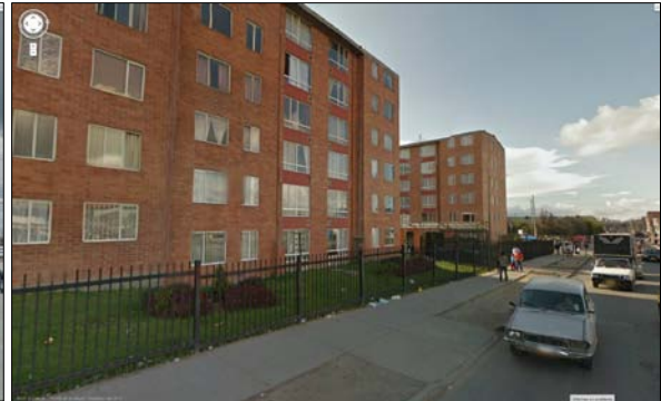
Vivienda en PH. Multifamiliares Tayrona. CL 52 A Sur con AV Ciudad de Cali
