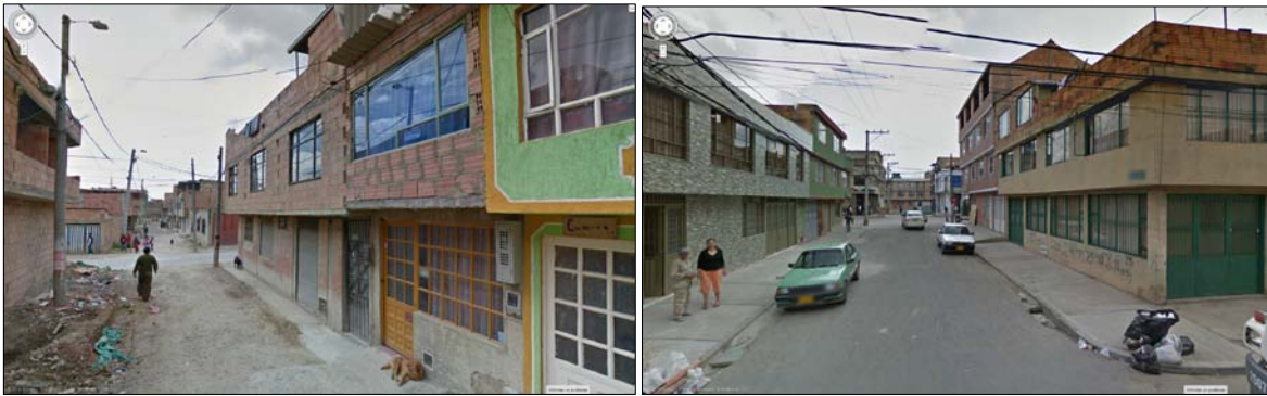
Vivienda en NPH. Barrio Villas del Progreso. KR 88 I con CL 72 Sur
